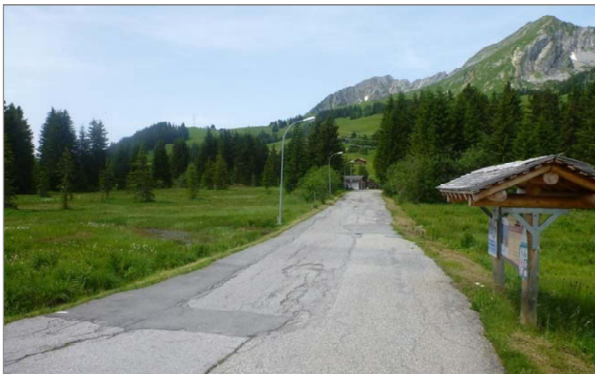
Situation actuelle de la route d'accès au camping
